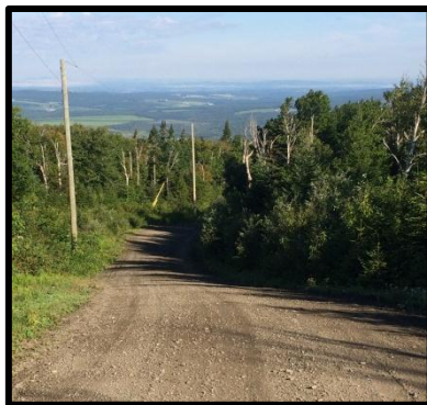
Chemin Centennial après les travaux de réparation, en août 2015.
